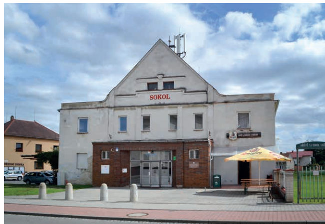
Sokolovna Lužice – před rekonstrukcí
