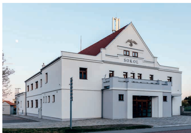
Sokolovna Lužice – po rekonstrukci
