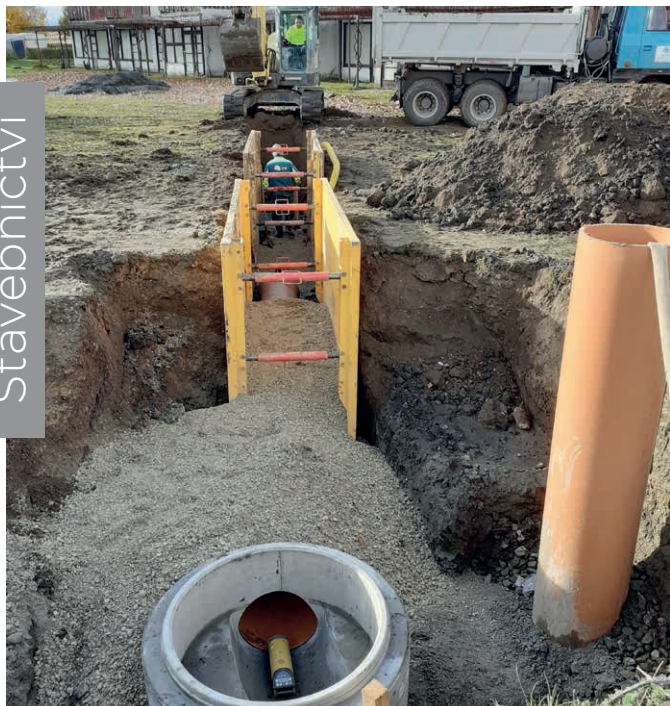
Pasohlávky – rekonstrukce kanalizace
