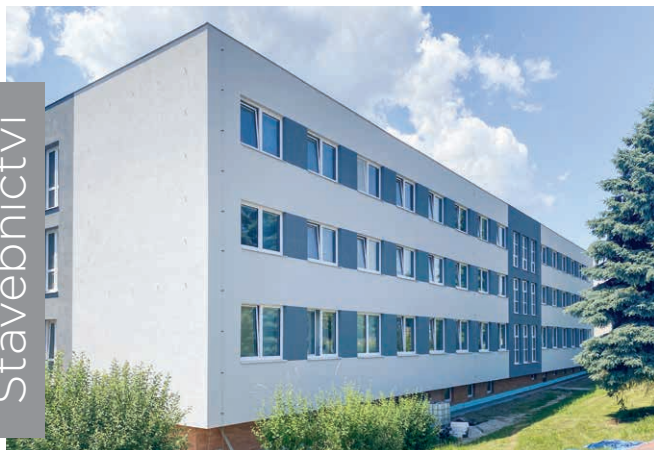
Control Invest projekt, s.r.o Bzenec – zateplení objektu
