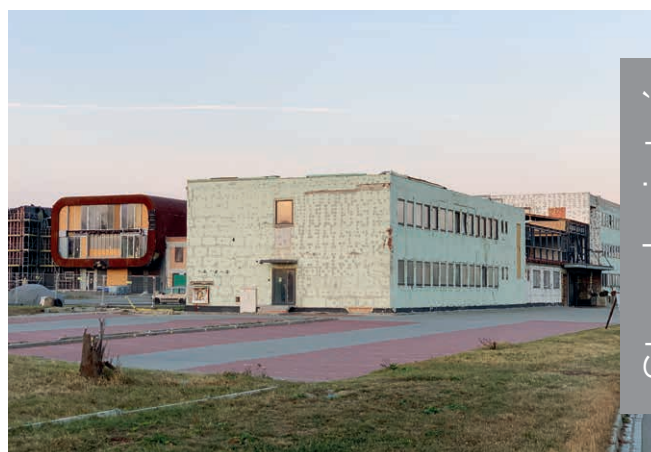
Rekonstrukce areálu MND v Lužicích
